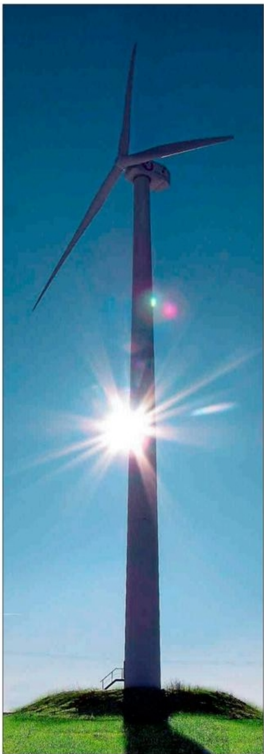
Die geplanten Anlagen messen bis zur Rotorspitze 180 Meter – mehr als der Fernsehturm auf der Angelburg. (Foto: Valentin)
